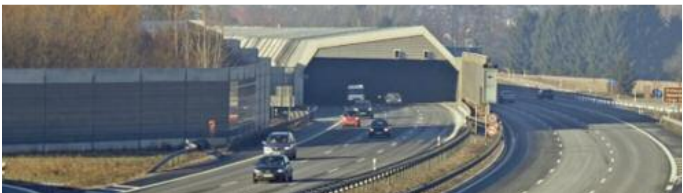
Autobahn A3 - Autobahneinhausung Ausfahrt bei Hösbach Fahrtrichtung Würzburg (Fotograf: Heiko Dassow)
