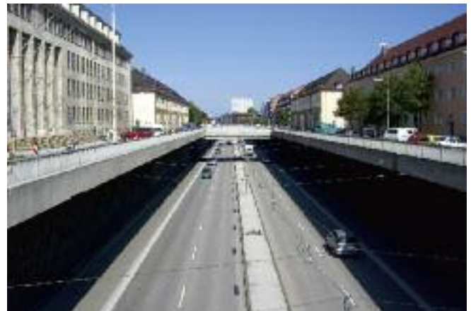
▲ München, McGraw-Graben, offene Troglage mit Überführungsstraße (Quelle: Wikimedia Commons, Autor: Maximilian Dörbbecker, Chumwa)
